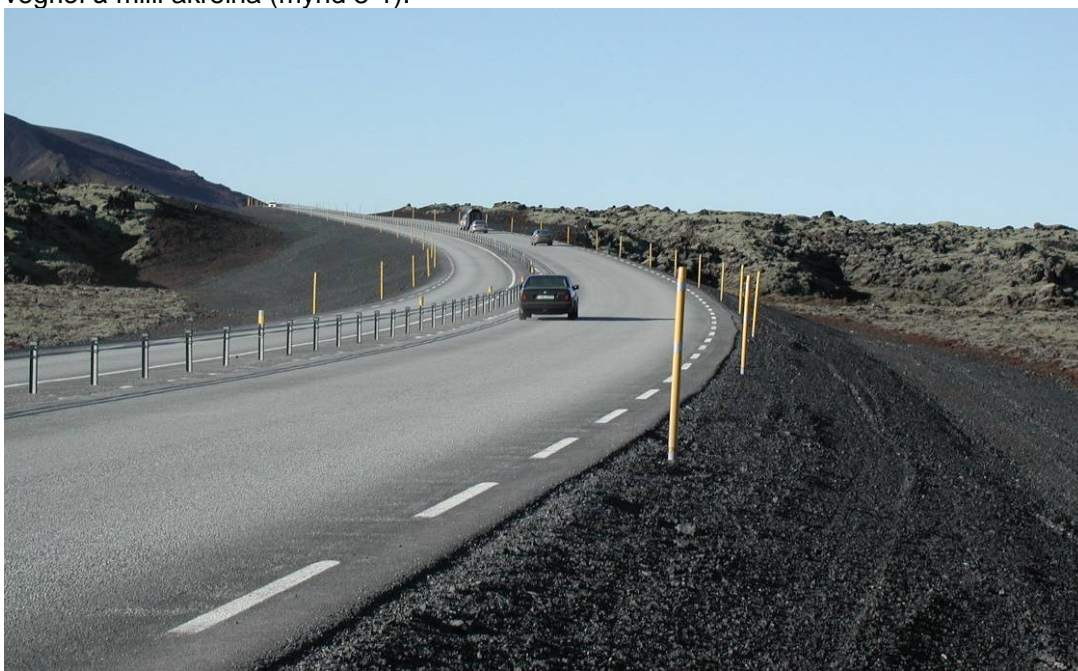
Mynd 3-1 Suðurlandsvegur í Svínahrauni, 2 +1 vegur (mynd Vegagerðin, APÁ)
